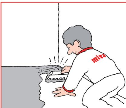
Для равномерного распределения смеси по углам или если нужно нанести тонкий слой смеси, используется кельма с зазубринами.
