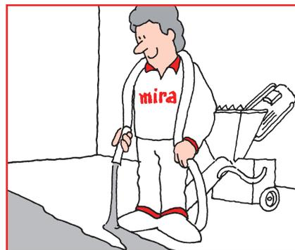
При нанесении смеси на большую площадь, выгоднее использовать смеситель/насосную установку для самовыравнивающих смесей.
