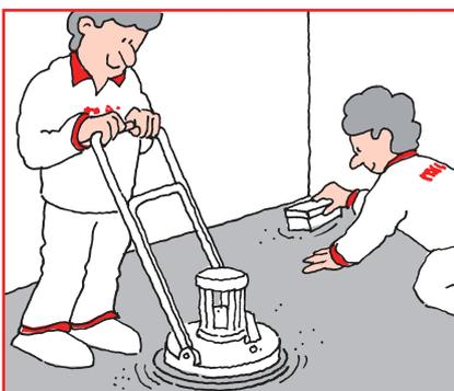
Если сверху будут укладываться ковровые, виниловые покрытия и т.п., поверхность должна быть отшлифована сразу же после высыхания.
